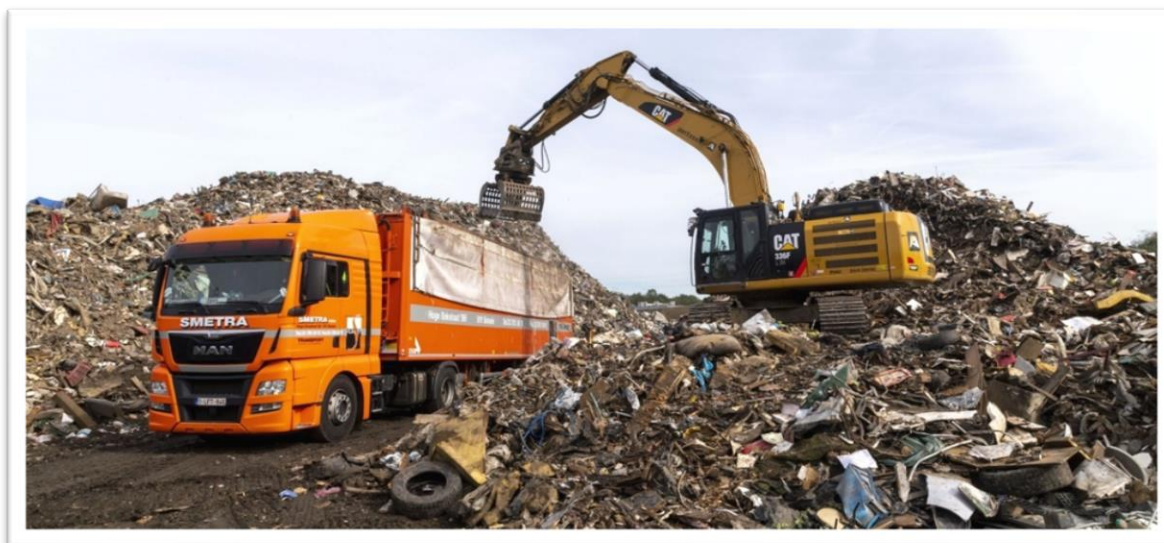
Evacuation des déchets générés par les inondations - Site du Wérihet - Wandre
