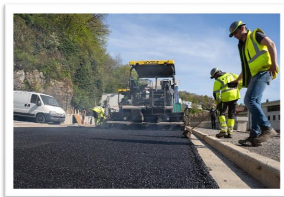
Réparation d'une voirie régionale
