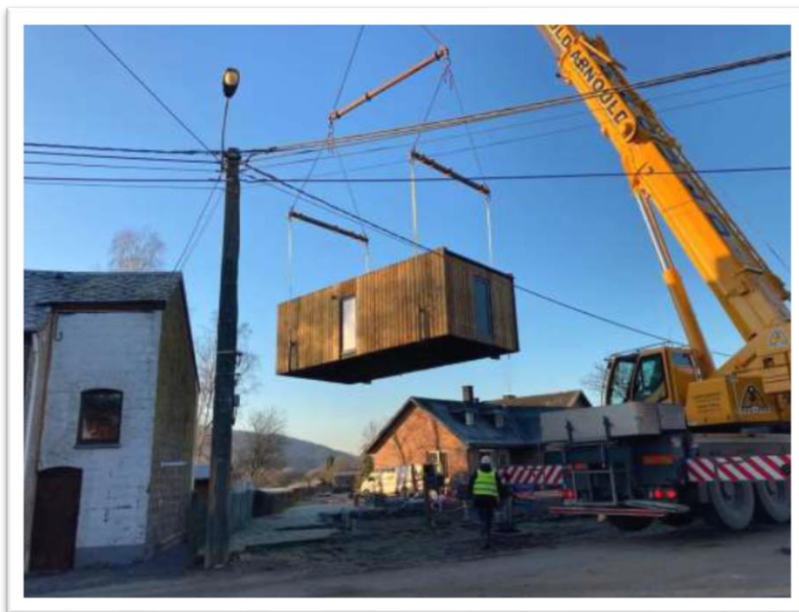
Installation d'habitat modulaire à ROCHEFORT
