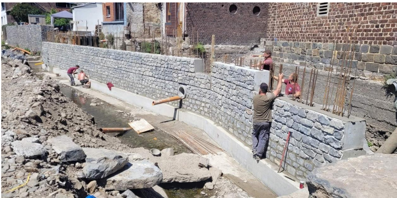
Des travaux en cours de réparation de berges contribuent déjà à la reconstruction résiliente des berges (Vallée de la Vesdre - Vaux-sur-Chèvremont - Rue Namont, Juin 2022)
