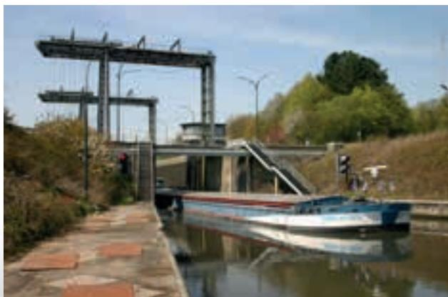
Gosselies : L'écluse n°2F de Gosselies vue depuis le bief amont de l'ouvrage. Mis en service le 8 juin 1958, l'ouvrage permet d'effacer une chute de 7,20 mètres. © Michel Maigre
