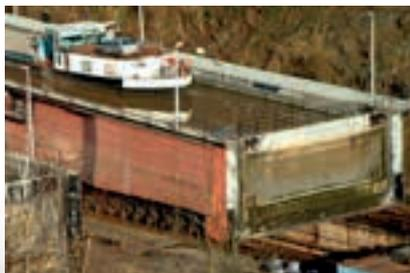
Vue d'un des deux bacs transporteur. Chaque bassin affiche 91,12 mètres de longueur, 12 mètres de largeur, 5 mètres de hauteur et pèse entre 5000 et 5700 tonnes, en fonction de la hauteur d'eau. © MAIGRE Michel
