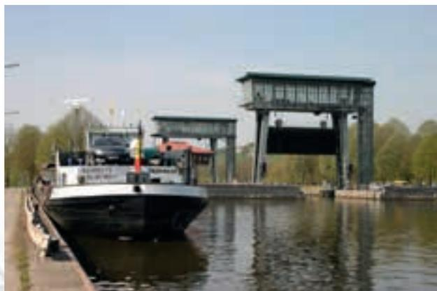
Ittre : Vue de l'écluse n°5F. Construite hors sol, elle figure parmi les écluses les plus grandes de Belgique. Elle présente les caractéristiques utiles suivantes : une longueur de 90 mètres, une largeur de 12 mètres, et un mouillage sur le seuil de 3,50 mètres. © Michel Maigre
