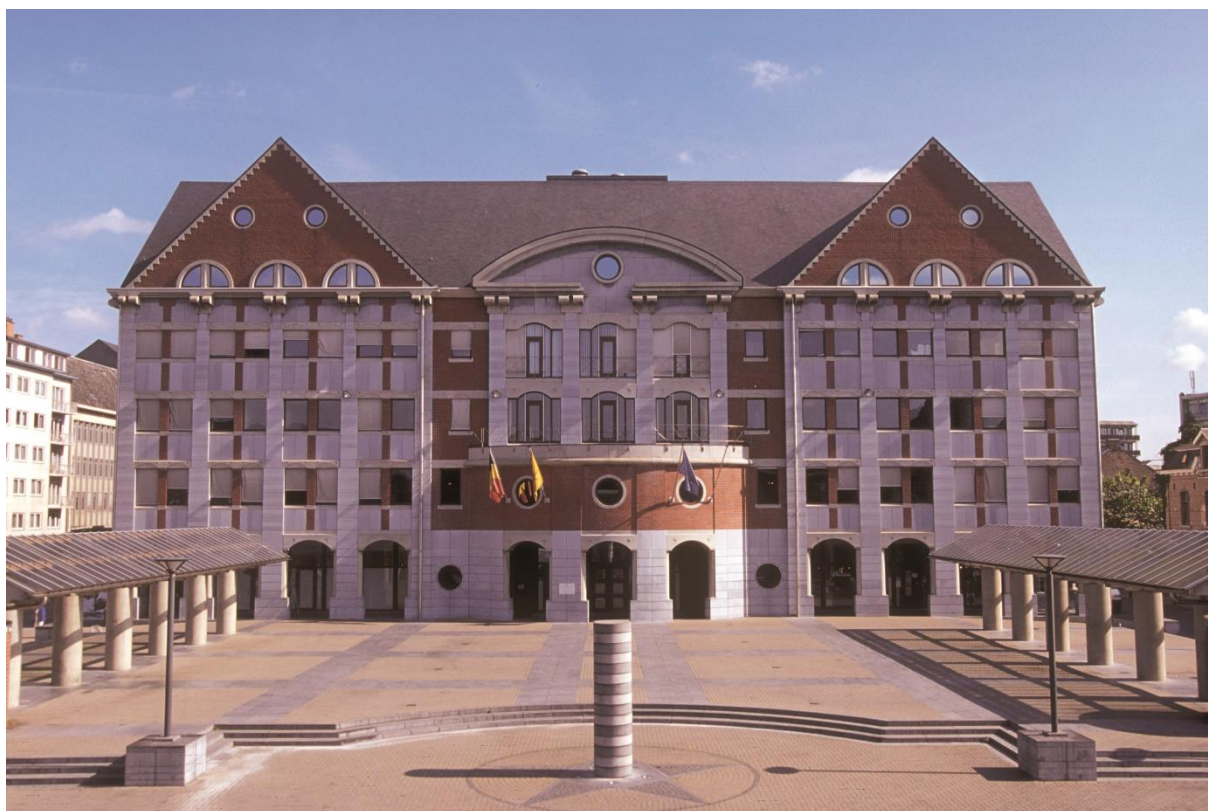
Vue du bâtiment du SPW Place de la Wallonie à Jambes © SPW-SG/J-L CARPENTIER
