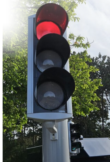
Lanternes avec lentilles translucides sans effet fantôme © SPW MI - DSTI
