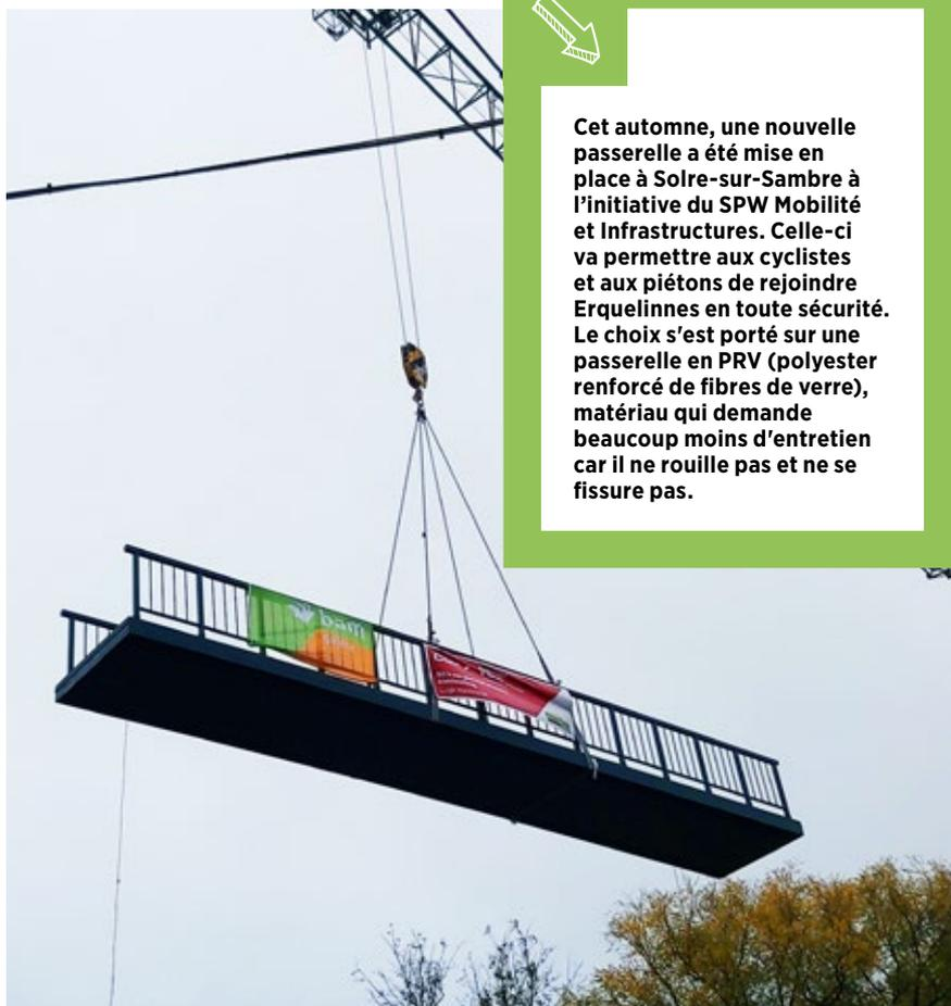
Cet automne, une nouvelle passerelle a été mise en place à Solre-sur-Sambre à l'initiative du SPW Mobilité et Infrastructures. Celle-ci va permettre aux cyclistes et aux piétons de rejoindre Erquelinnes en toute sécurité. Le choix s'est porté sur une passerelle en PRV (polyester renforcé de fibres de verre), matériau qui demande beaucoup moins d'entretien car il ne rouille pas et ne se fissure pas.
