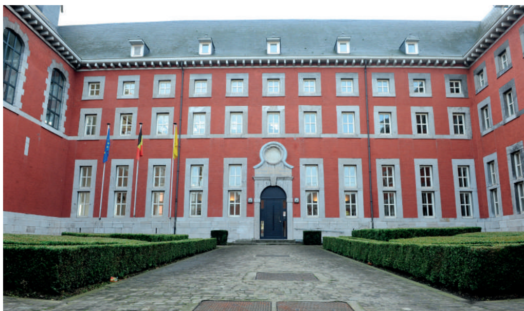
Au centre de Liège, le bâtiment du Vertbois, autrefois hospice pour pauvres incurables et filles repenties, boulangerie militaire puis orphelinat, accueille le CESW depuis une quinzaine d'années.
